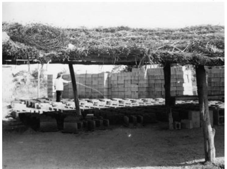
Fabricación de Bloques
