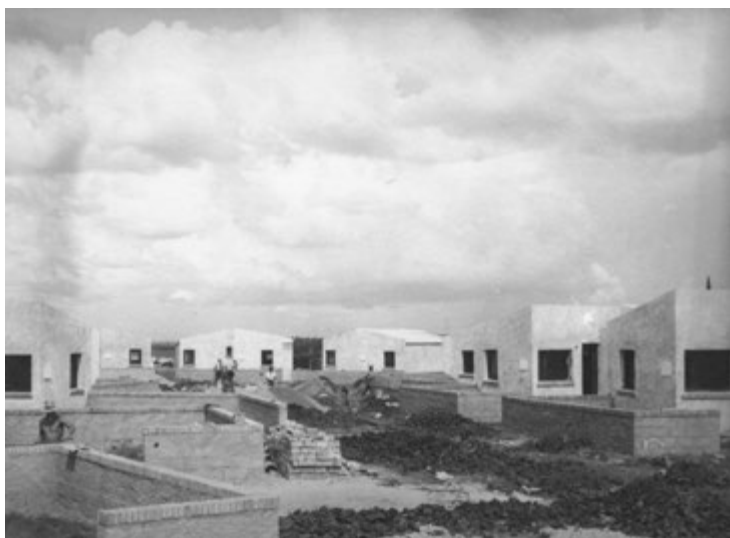
Cooperativa Isla Mala en obra
