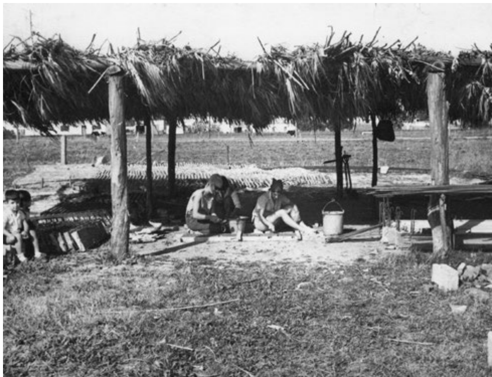
Elaboración de Losetas de Ladrillo
