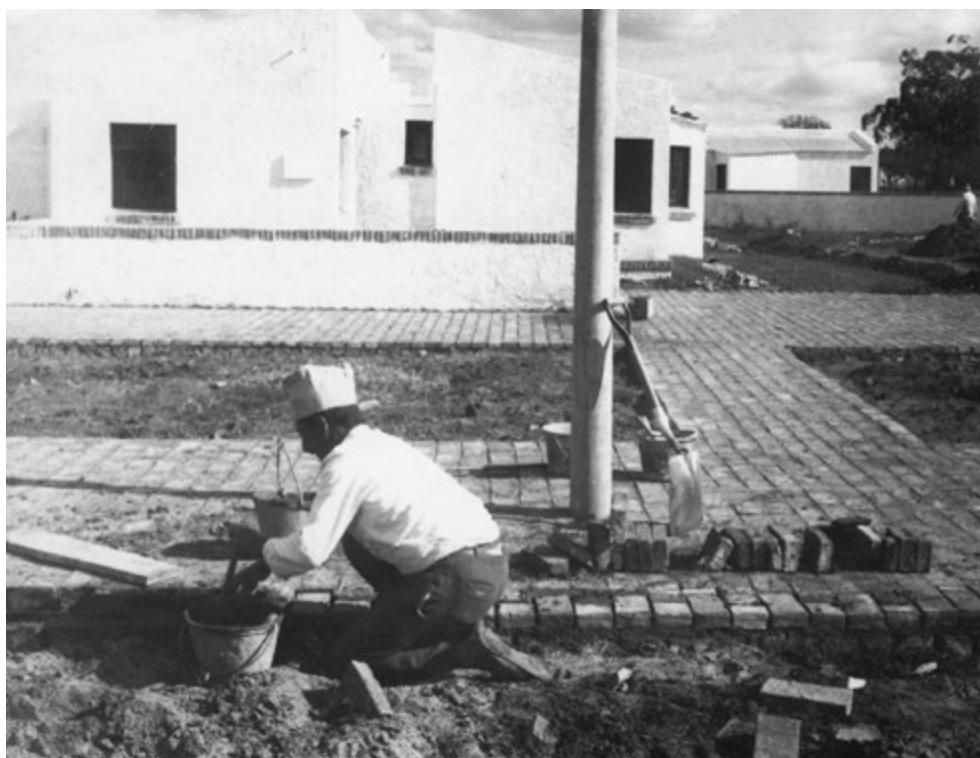
Colocación de ladrillos en pavimento, Cooperativa Isla Mala 1970
